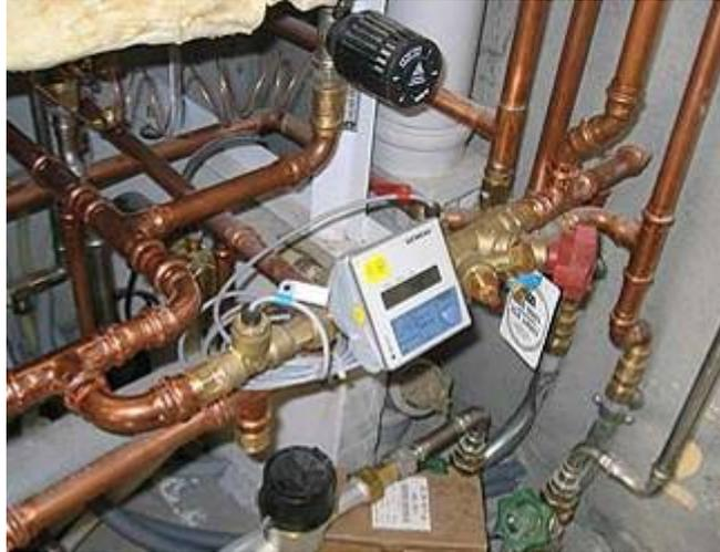
*Fig. 2.6.4.1: Metering device.*
